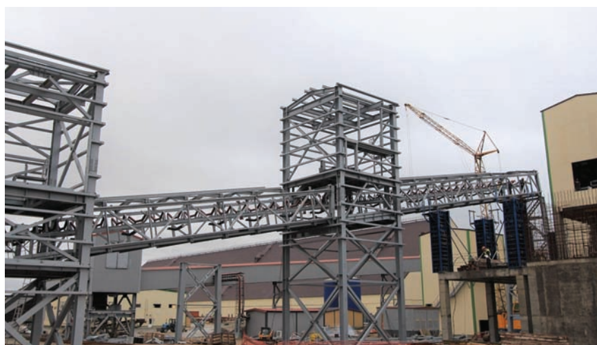
НПО «АКОНИТ» ВЕДЕТ МОНТАЖ, СТРОИТЕЛЬСТВО И ПУСКОВЫЕ РАБОТЫ, МТП «УСТЬ-ЛУГА», МАЙ 2020
