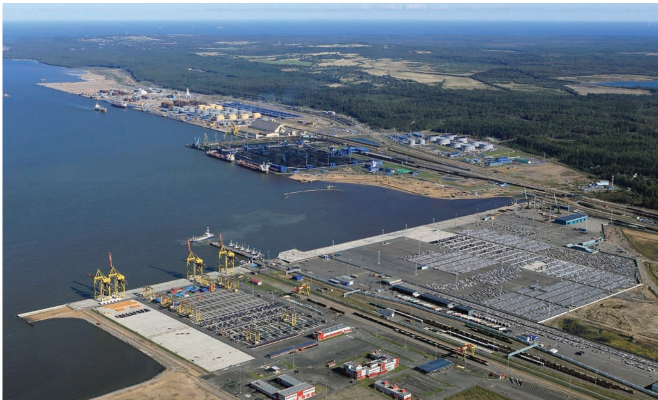
В ПОРТУ УСТЬ-ЛУГА РЕАЛИЗУЕТСЯ ПРОЕКТ СТРОИТЕЛЬСТВА ТЕРМИНАЛА МИНУДОБРЕНИЙ МОЩНОСТЬЮ 25 МЛН ТОНН «УЛЬТРАМАР». ФОТО С САЙТА WWW.ULTRAMAR.RU
